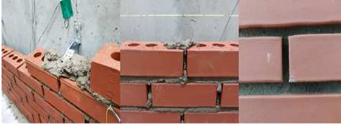
[그림 3-22] 치장조적벽체 시공
